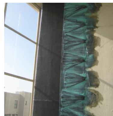
(d) Wall edge strengthening (Non-conventional)
